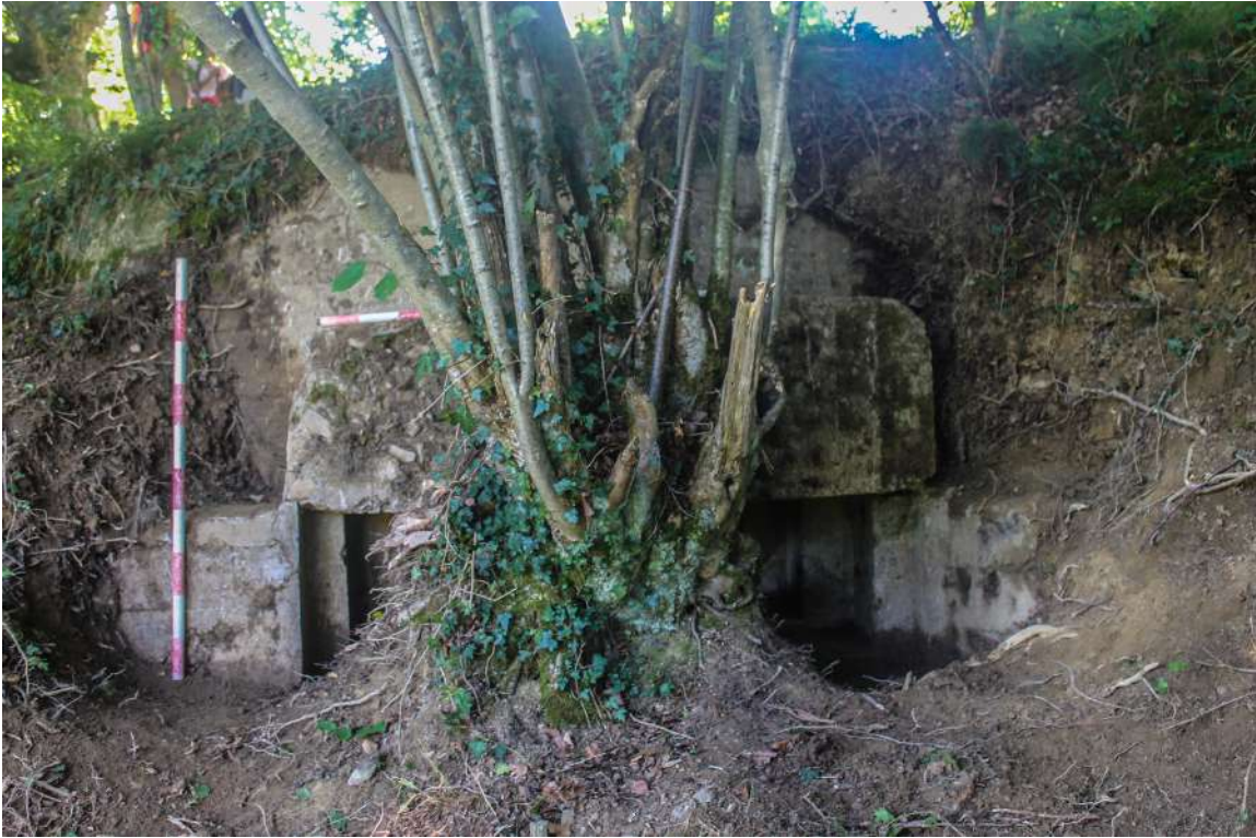
Búnker nº15 del Centro de Resistencia 209 (Tres Hayas)
